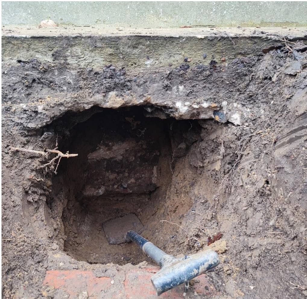
Fot.3 Fundament kamienny na zaprawie wapiennej. Posadowienie ok. 1m od opaski betonowej
